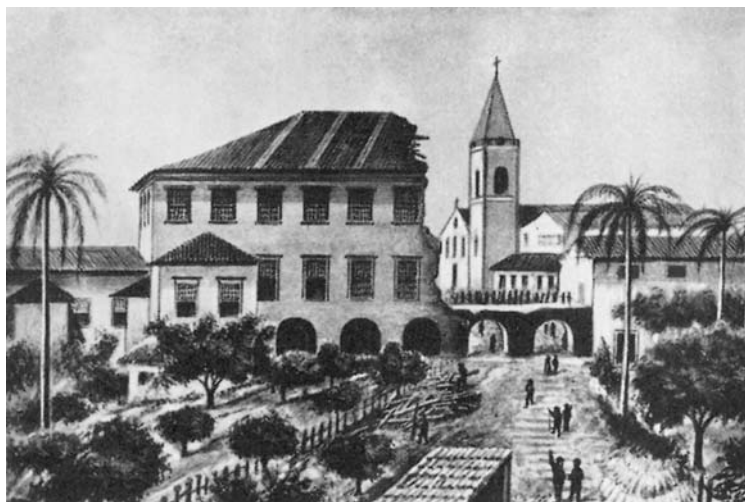
Demolição do prédio do Barão de Itapetininga para construção do Viaduto do Chá
