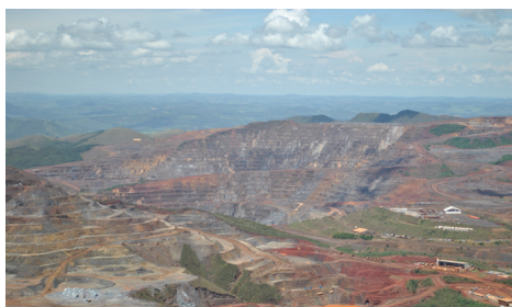
Cava do Complexo Fábrica, da Vale, no município de Congonhas - MG
