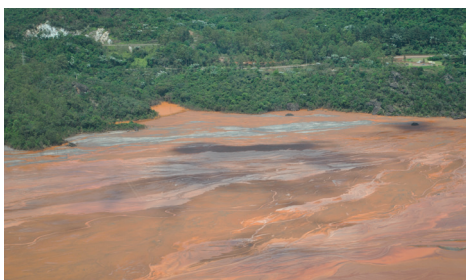
Barragem de rejeitos de minério de ferro da mina Casa de Pedra, da CSN, em Congonhas - MG
