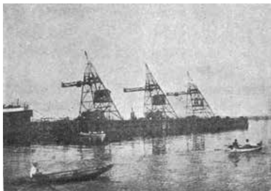
Serviço de carga e descarga no porto da Manaus Harbour
