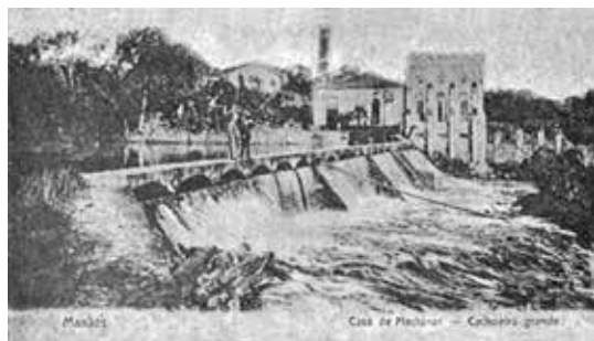
Casa de máquinas – Cachoeira Grande
