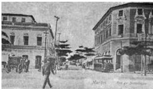
Rua da Instalação
