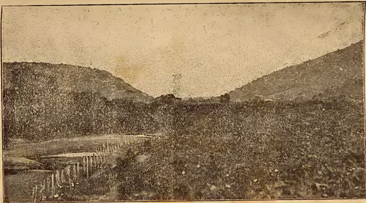
Boqueirão do rio Quixeramobim, vista de jusante.
