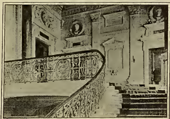
Escalier de la Cour de cassation.
