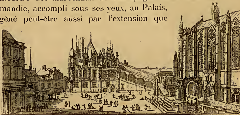
Vue de la Sainte-Chapelle et de la Chambre des comptes de Paris.
