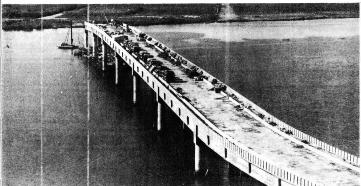
Ponte ligando Iguape à Ilha Comprida: no futuro, passagem para 1,5 milhão de pessoas.
