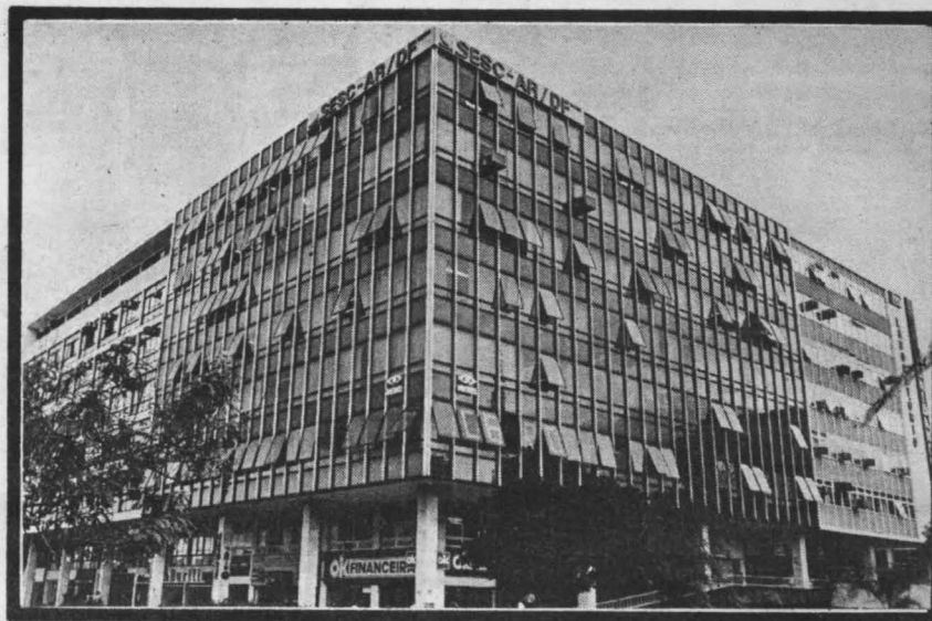
Prédio do SESC de Brasília, no Setor Comercial Sul
