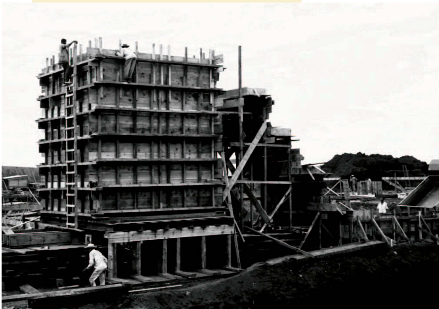
Construção do edifício do Congresso Nacional (31 de maio de 1958)
