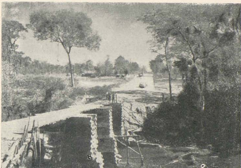
N.º 3 — Estrada de Anápolis para Belém. Ponte sobre o Rio São Patricio
