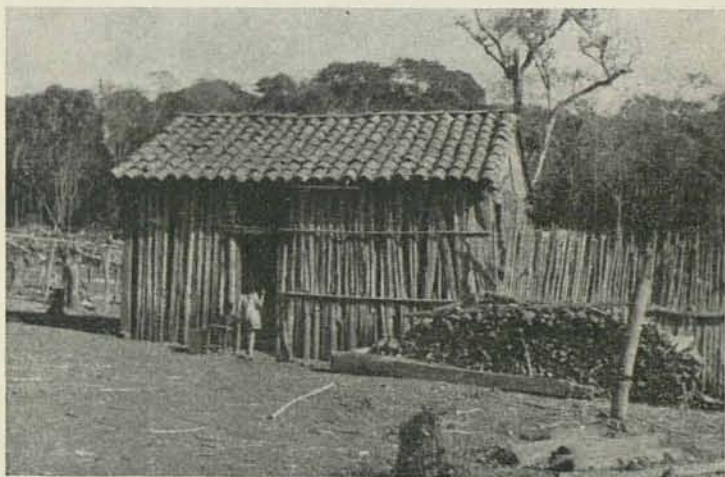
Fig. 15 — Casa típica de colono, construída de pau a pique, enquanto aguarda a habitação definitiva, que será edificada pela administração da Colônia.
