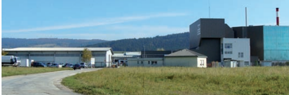
Incinerador francês de Gilly-sur Isère, fechado em 2001 por emitir volume de dioxinas acima do permitido
