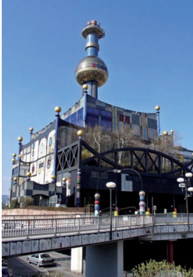
Usina de recuperação energética de lixo, edifício que se destaca na paisagem de Viena, na Áustria, trata 720 toneladas de resíduos por dia
