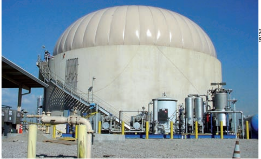
Lixo já faz parte de modernas cadeias de geração de energia. Em Rialto, na Califórnia (EUA), o gás metano produzido a partir de gordura de cozinhas é convertido em hidrogênio e, então, em energia eletroquímica
