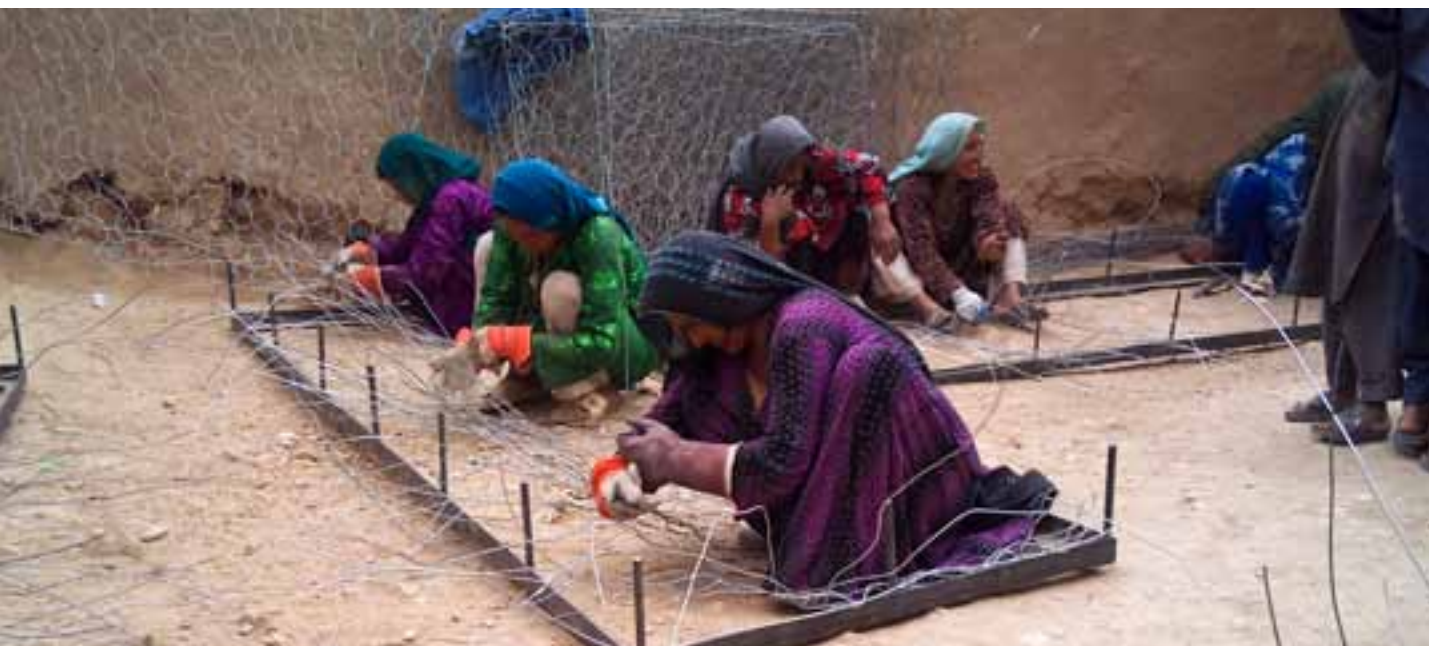
Mujeres preparan cestas de alambre o gaviones como parte del proyecto de mejora del acceso a las zonas rurales que financia Suecia en el norte de Afganistán. Los gaviones se rellenarán con piedras y se utilizarán para rehabilitar las carreteras en las provincias de Sar-e-pul y Samangan. Fotografía: UNOPS
