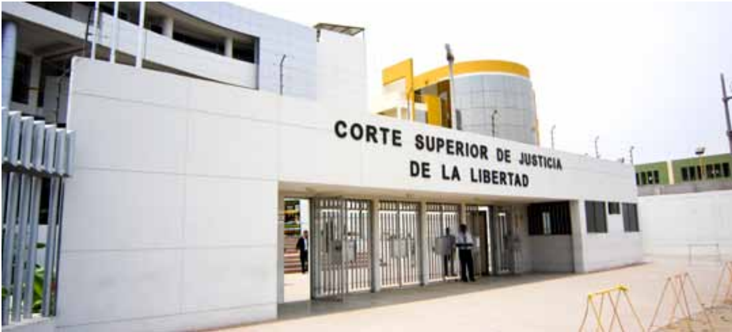
La Corte Superior de Justicia de la región peruana de La Libertad forma parte de un proyecto de infraestructura ejecutado por UNOPS en nombre del Poder Judicial de Perú y el PNUD. Fotografía: UNOPS/Aida Ariño-Fernández
