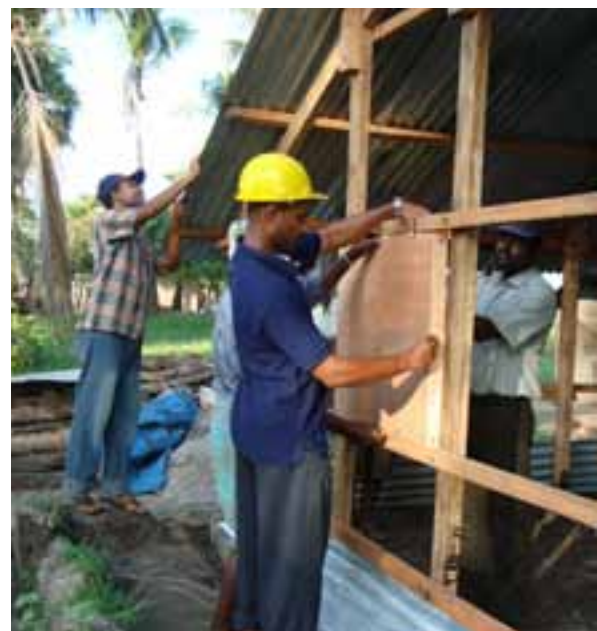
Construcción por parte de UNOPS en nombre de múltiples donantes de un refugio de transición para cobijar a una familia de desplazados internos en Sri Lanka.
