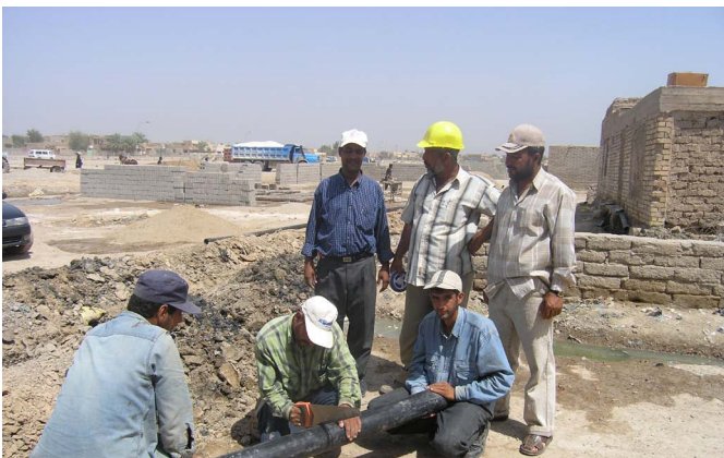
Nuevas tuberías como parte del Proyecto de seis redes de abastecimiento de agua potable en Iraq
