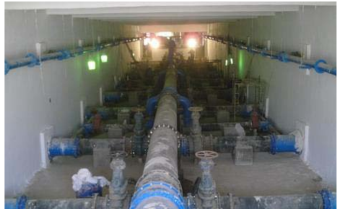
Sistema de tuberías rehabilitado en Kerbala, Iraq
