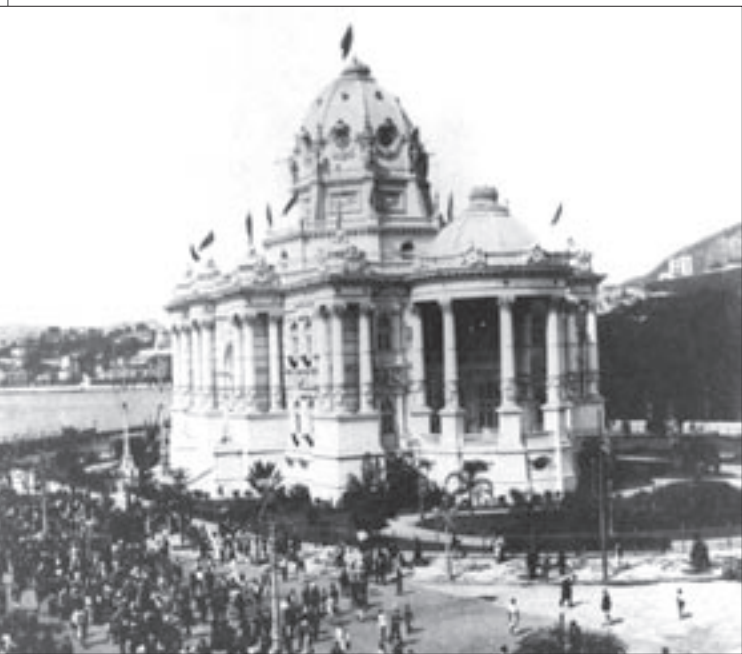
O Palácio Monroe foi demolido na década de 70 sob o argumento de que atrapalhava as obras do metrô no Rio de Janeiro
