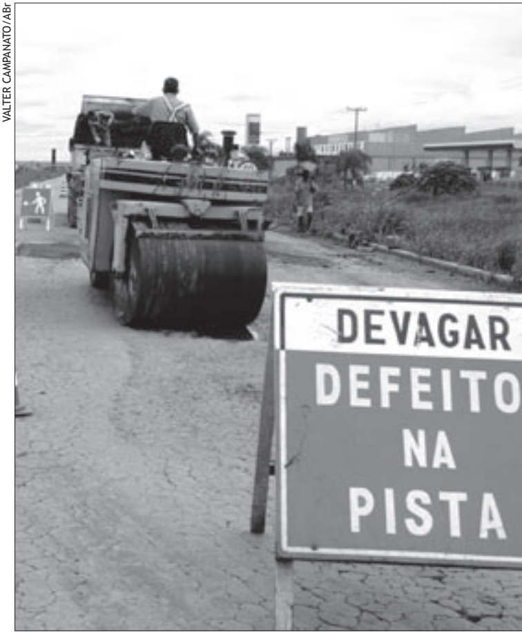
Obras de asfaltamento em rodovia próxima a Brasília: a Operação Tapa-Buracos é insuficiente para resolver problema, diz a CNT
