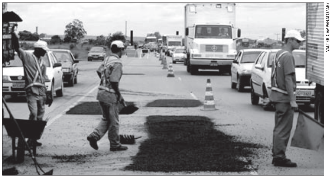
Buracos cobertos na BR-070, na saída de Brasília: trabalho de emergência recebeu críticas e elogios
