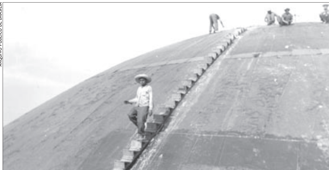
Operários trabalham na construção da cúpula do Senado, em Brasília, durante o governo JK
