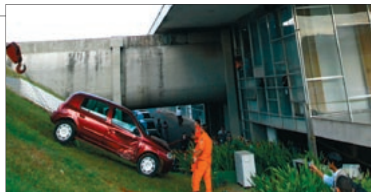
Ao cair, Renault Clio atingiu sistema de ar-condicionado da Casa, provocando vazamento
