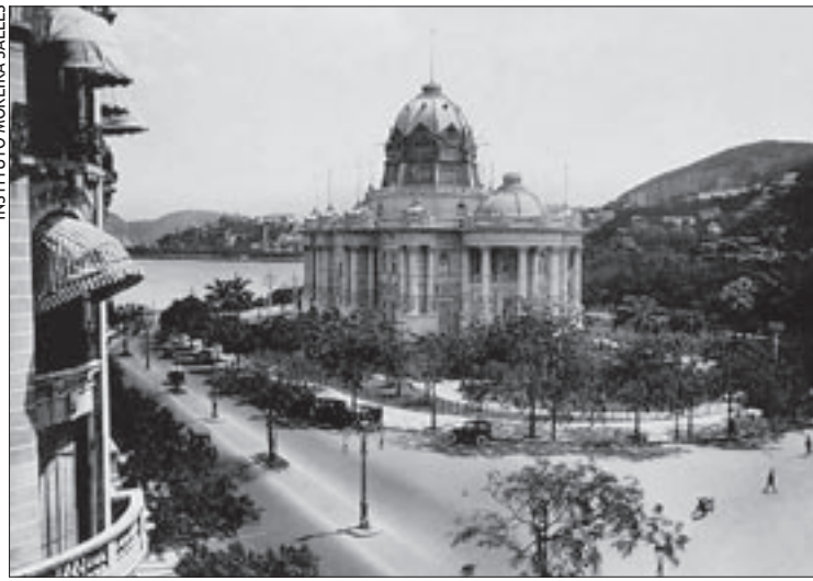
Demolido em 1976, o Palácio Monroe, na região central do Rio, foi a segunda sede do Senado: TV visita 180 anos de história
