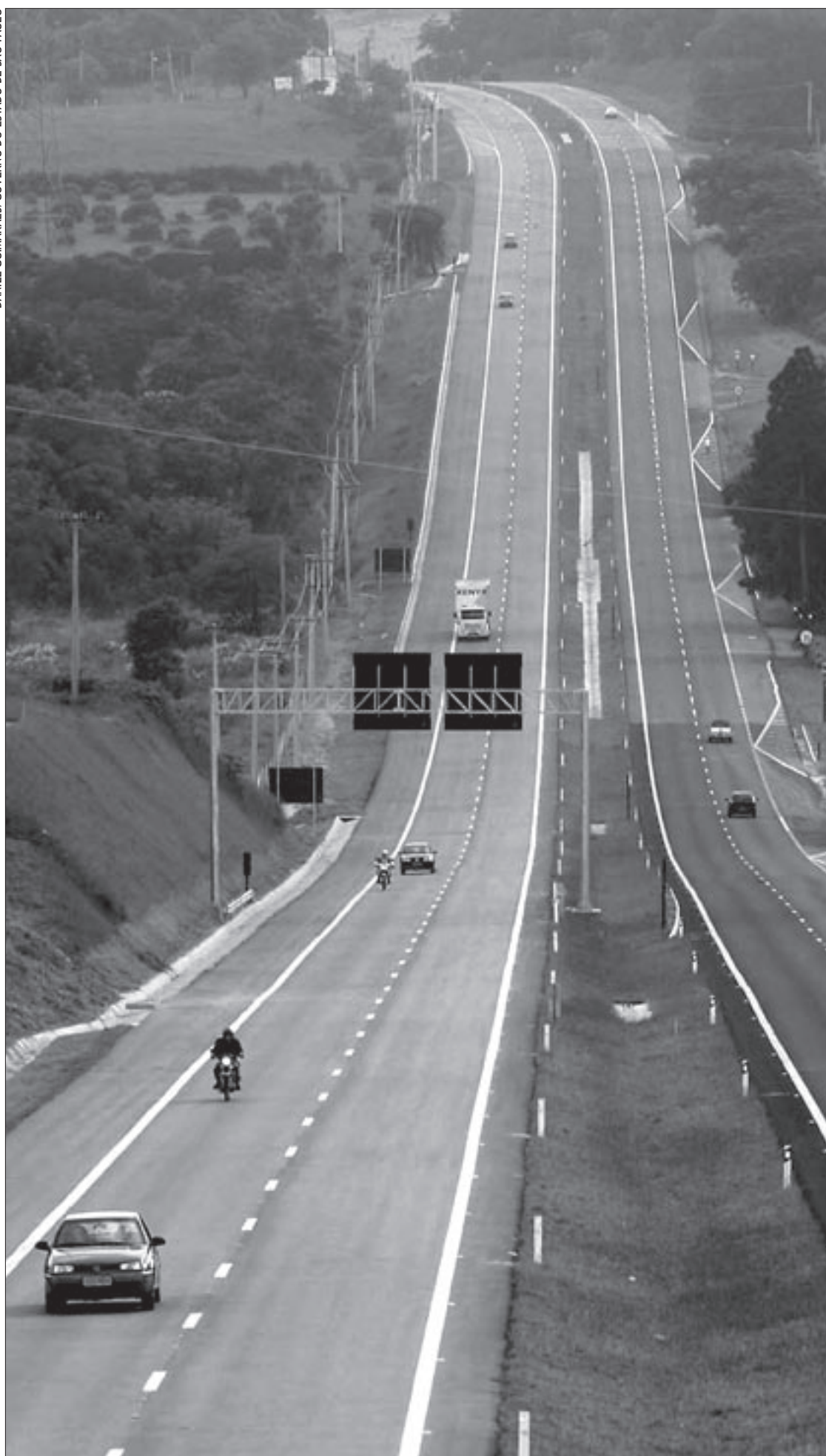
Rodovia SP-300, em São Paulo: 90% do Plano Piloto de Investimentos vão para o setor de transportes
