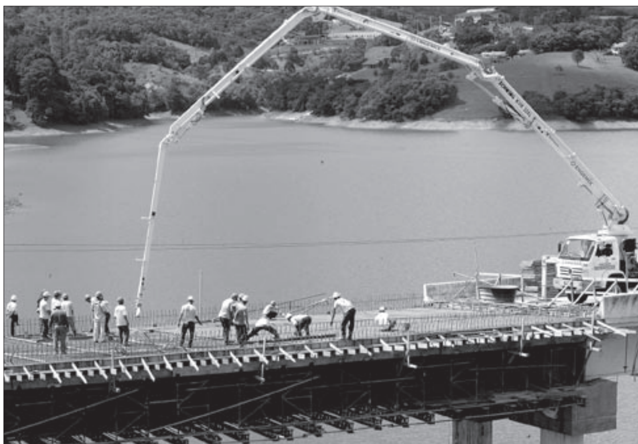
Ponte em reconstrução no Paraná: governo criou PPI para assegurar continuidade dos investimentos públicos
