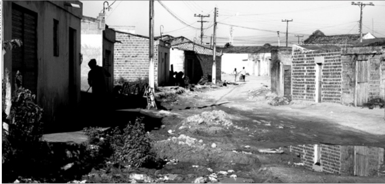
Loteamentos já existentes, como em Manari (PE), foram excluídos da exigência de infra-estrutura básica para receber asfaltamento
