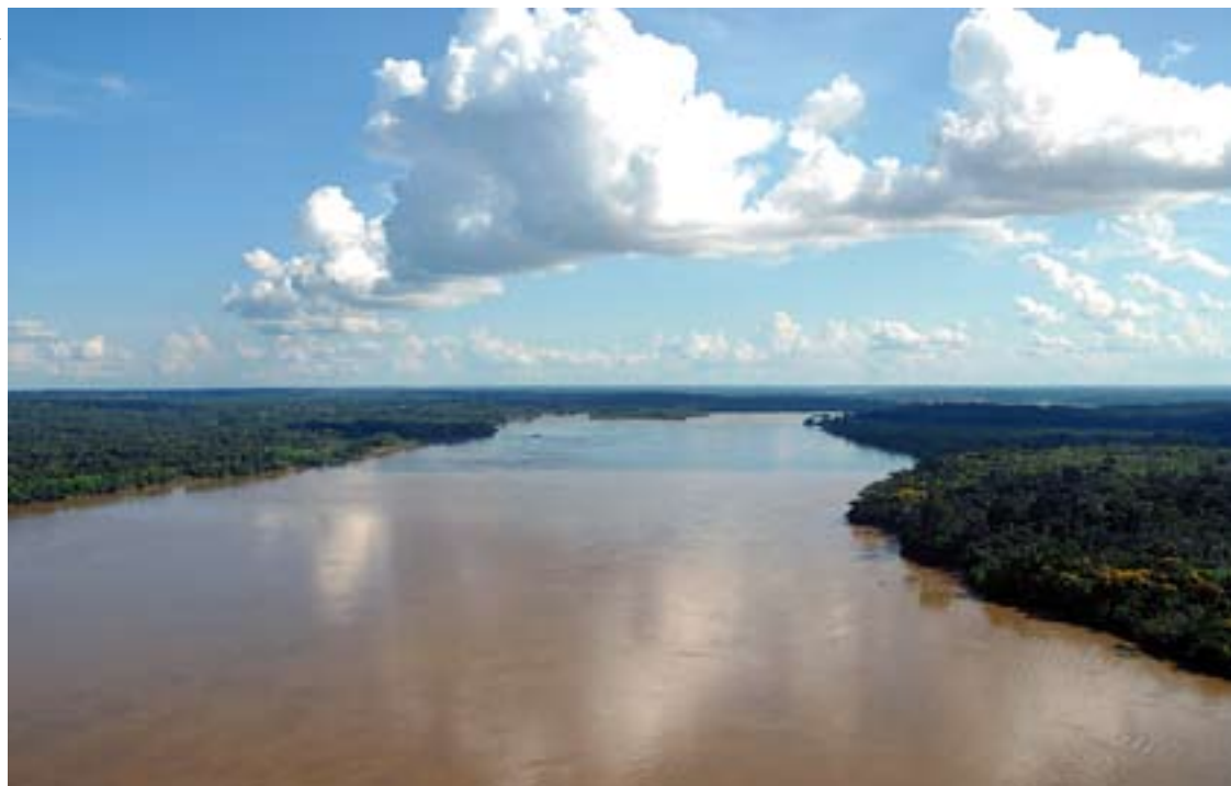
As duas obras que serão construídas no rio Madeira garantirão energia para o desenvolvimento do país, diz parlamentar
