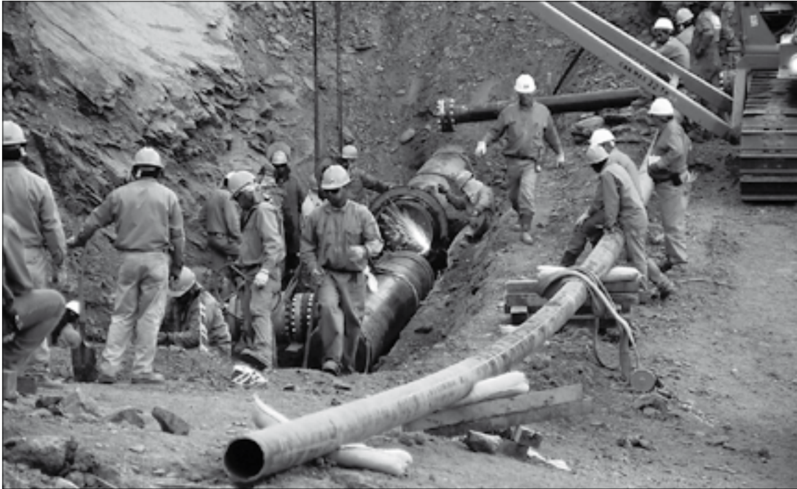
Operários constroem gasoduto: transporte é responsabilidade da Petrobras, que quer vender gás direto para indústrias
