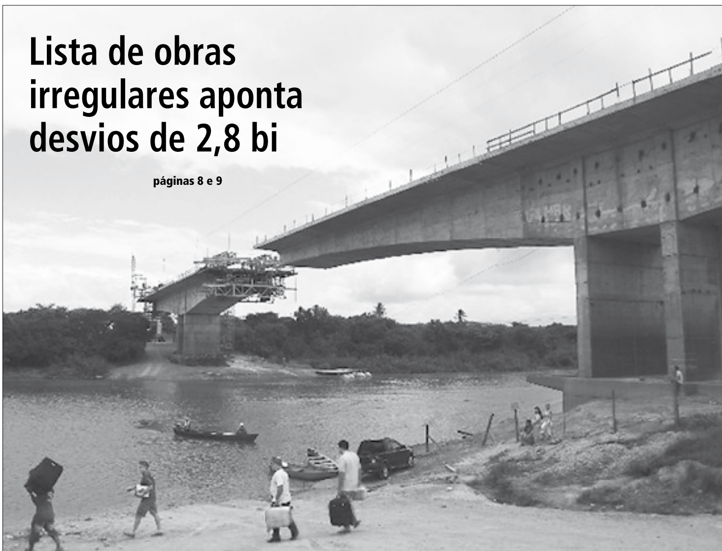
Ponte sobre o rio Itacutu, em Roraima, teve irregularidades apontadas pelo TCU. Travessia entre uma margem e outra continua sendo feita de barco
