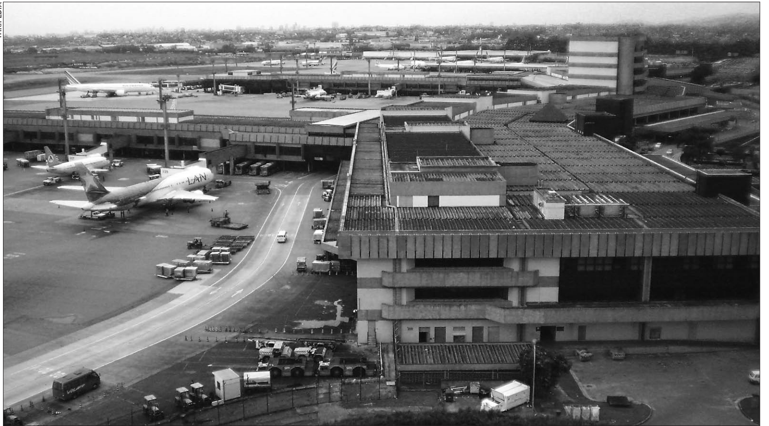
Obra no aeroporto de Guarulhos, na cidade de São Paulo, é uma das apontadas pelo Tribunal de Contas da União com indícios de irregularidades
