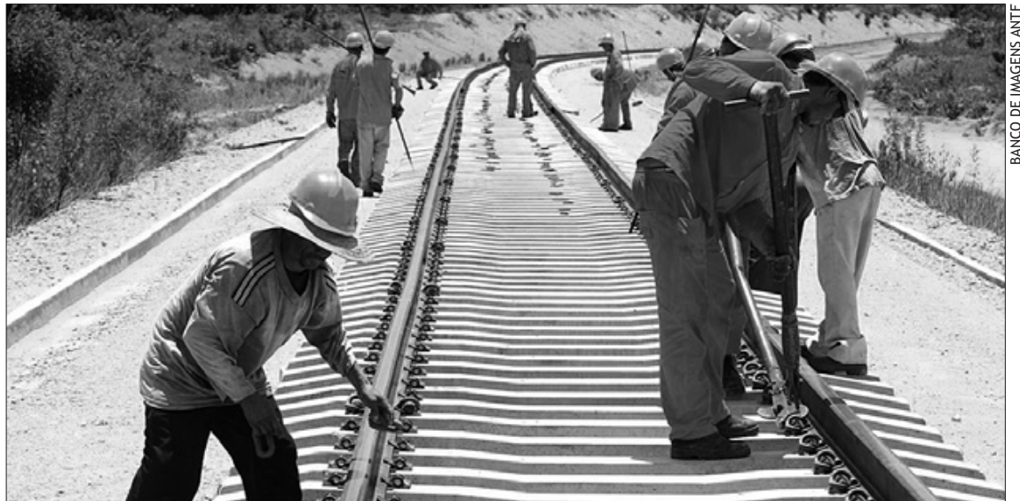
Homens trabalham no trecho Açailândia/Colinas (MA) da Ferrovia Norte-Sul, que quando concluída cortará sete estados
