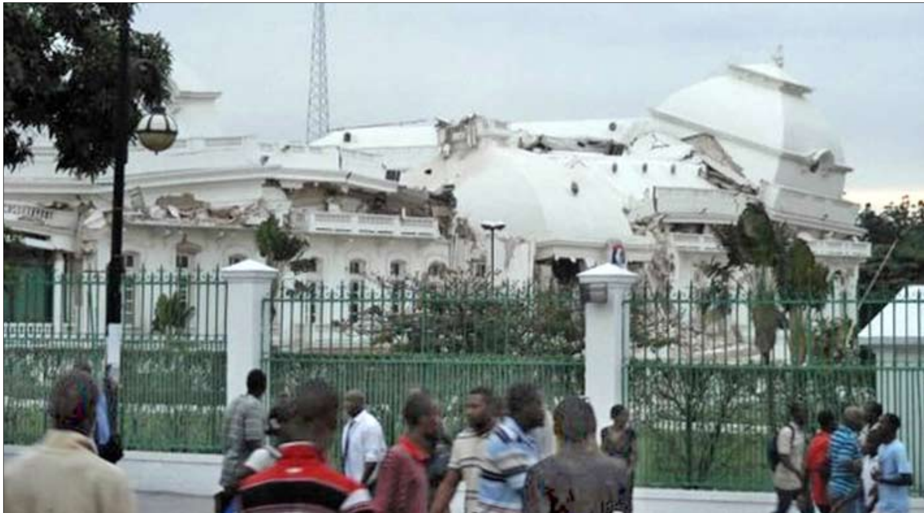
O Palácio Presidencial do Haiti, em Porto Príncipe, após desabamento em consequência do terremoto de 7 graus na escala Richter que atingiu o país na noite de terça-feira e derrubou vários prédios
