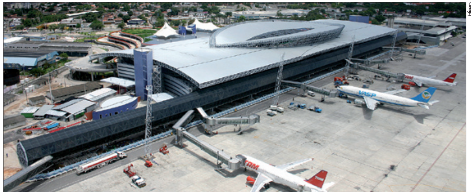
Aviões conectados a pontes de acesso no Aeroporto Internacional do Recife: hoje, pessoas com necessidades especiais têm que ser carregadas até as suas poltronas
