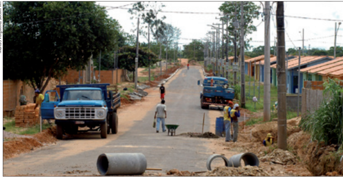
Mais de 50% dos brasileiros não são atendidos por serviço de esgotamento sanitário e 8 milhões não têm banheiro em casa
