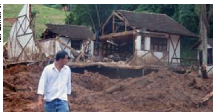
Proposta quer impedir a ocupação de áreas de risco sujeitas a desmoronamentos
