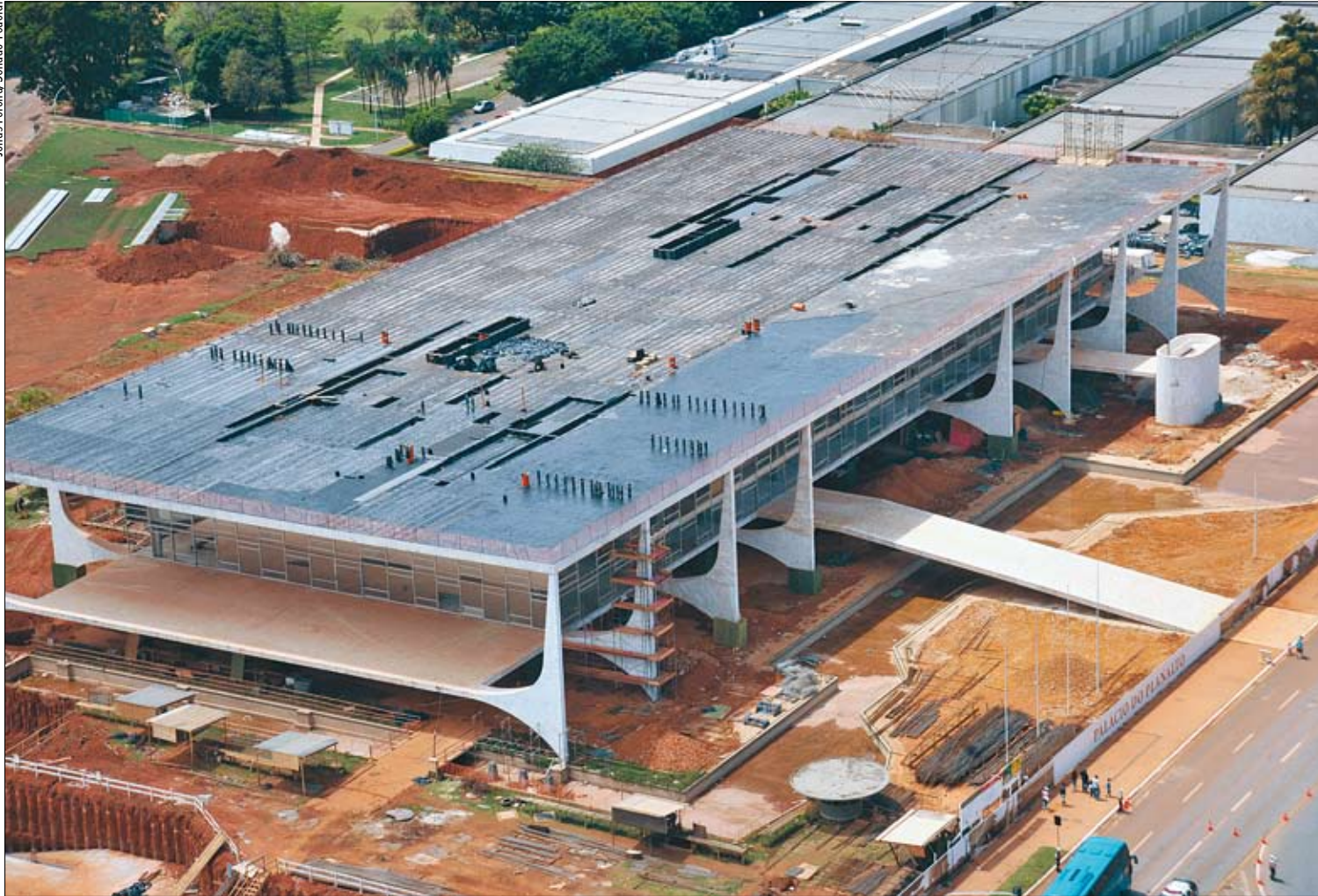
A reforma nos 36 mil metros quadrados, distribuídos em quatro pavimentos, foi orçada em R$ 88 milhões. Alvaro Dias considera que a obra deveria constar do PPA
