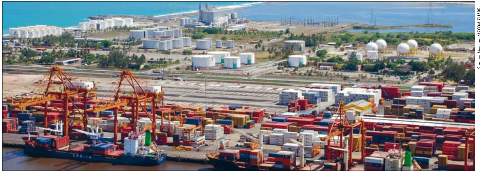
Vista aérea do Porto de Suape, em Pernambuco: atualmente, o transporte marítimo representa quase 80% do comércio brasileiro feito através de contêineres
