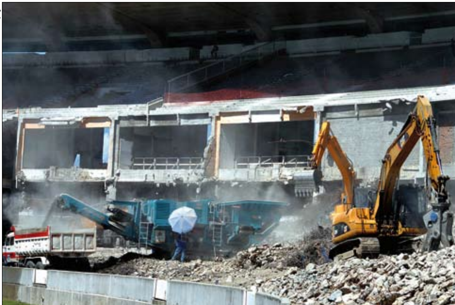
Canteiro de obras no Maracanã, no Rio de Janeiro: preparação do principal palco da Copa de 2014
