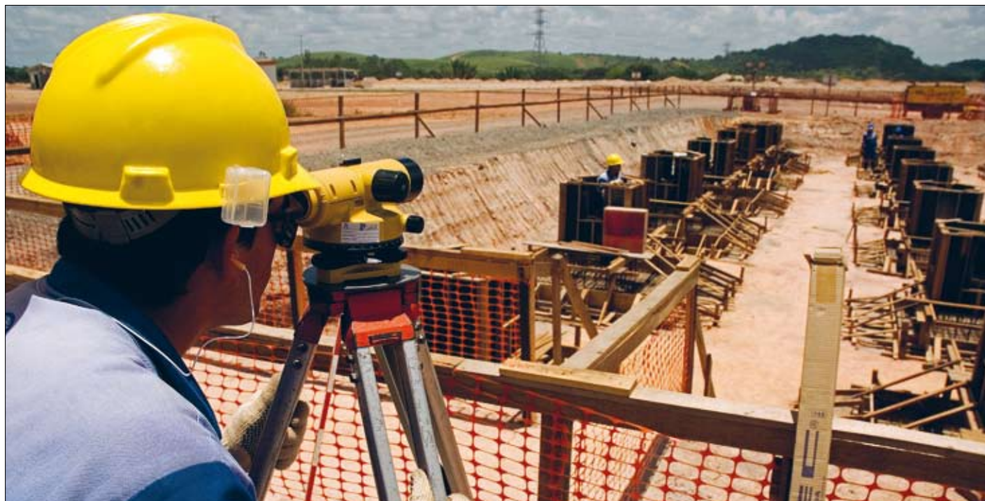
Obras da Refinaria Abreu e Lima, em Pernambuco: atividades das pequenas empresas de engenharia podem passar a ter tratamento tributário diferenciado
