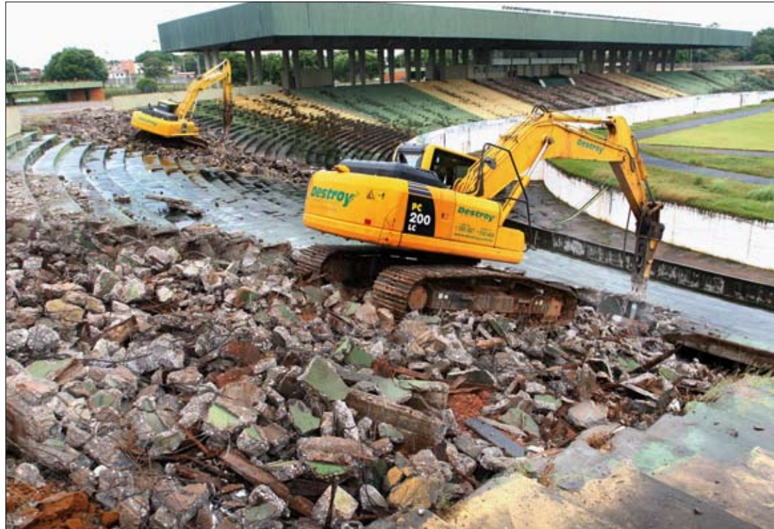
Início das obras da Arena Pantanal (Verdão), em Cuiabá: estádio terá uso múltiplo, para ser utilizado depois da Copa de 2014
