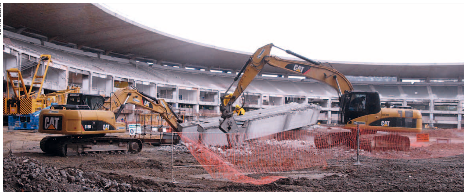
Obras no Estádio do Maracanã, no Rio de Janeiro, principal palco da Copa de 2014: cobertura estimada em R$ 197 milhões tem indícios de superfaturamento
