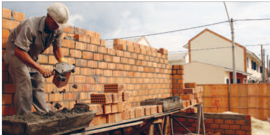
Pedreiro trabalha em conjunto habitacional: projeto incentiva moradia popular em município com indicadores sociais ruins
