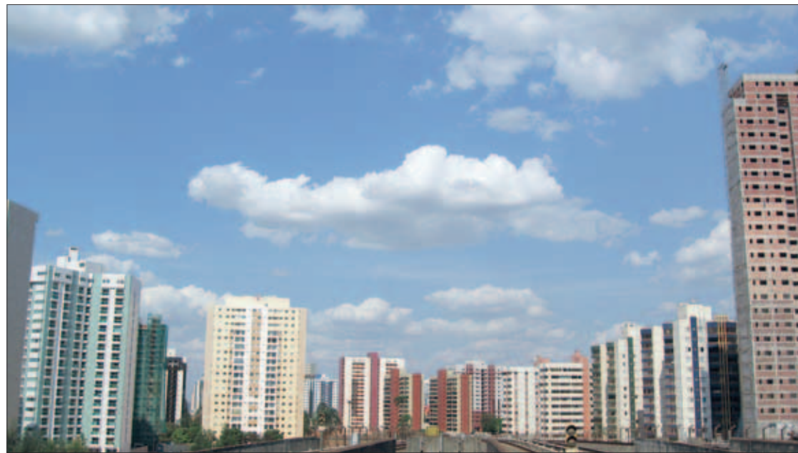
Arranha-céus em Águas Claras: pelas novas regras, construções nos arredores de Brasília precisam ser aprovadas pelo Iphan
