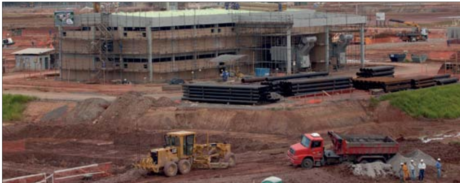
Projeto estabelece que obras do PAC — como a da Refinaria Abreu e Lima, em Pernambuco — poderão ser executadas mesmo sem sanção da lei orçamentária
