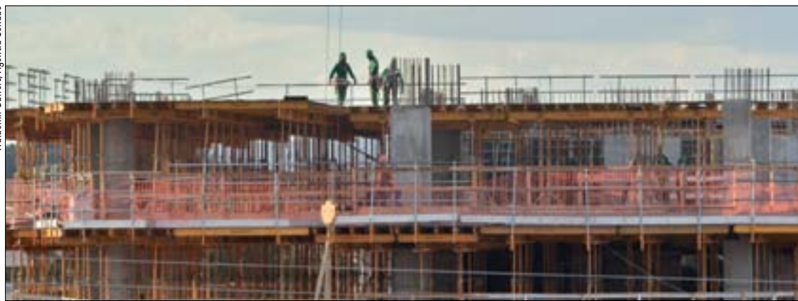
Prédio em construção em Brasília: pela proposta de Eduardo Lopes, indenização chegaria a 2% do valor contratado
