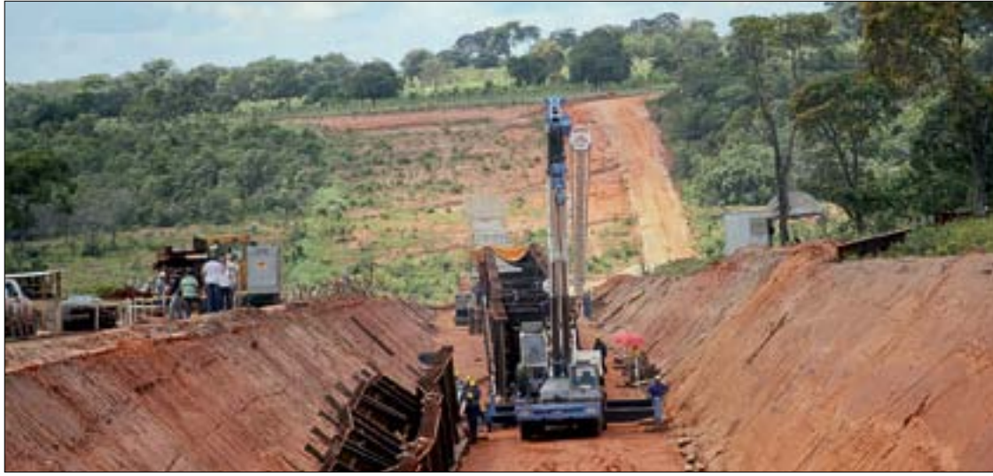
Construção da estrutura dos transportes rodoviário e ferroviário ficará a cargo da empresa, segundo a medida provisória
