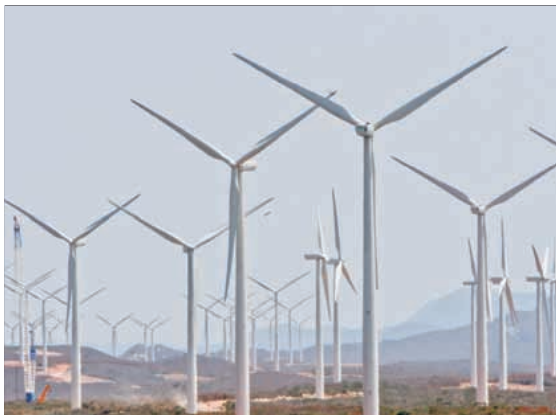
Parque de energia eólica na BA: Agripino citou 26 pontos de geração cuja energia não é transmitida por falta de infraestrutura
