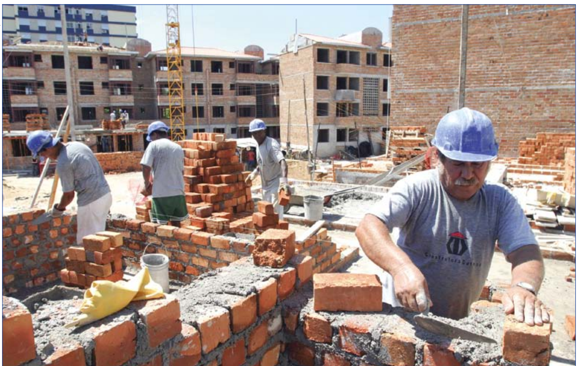
Pedreiros trabalham na construção de um condomínio em Porto Alegre: mercado imobiliário aquecido e obras atrasadas
