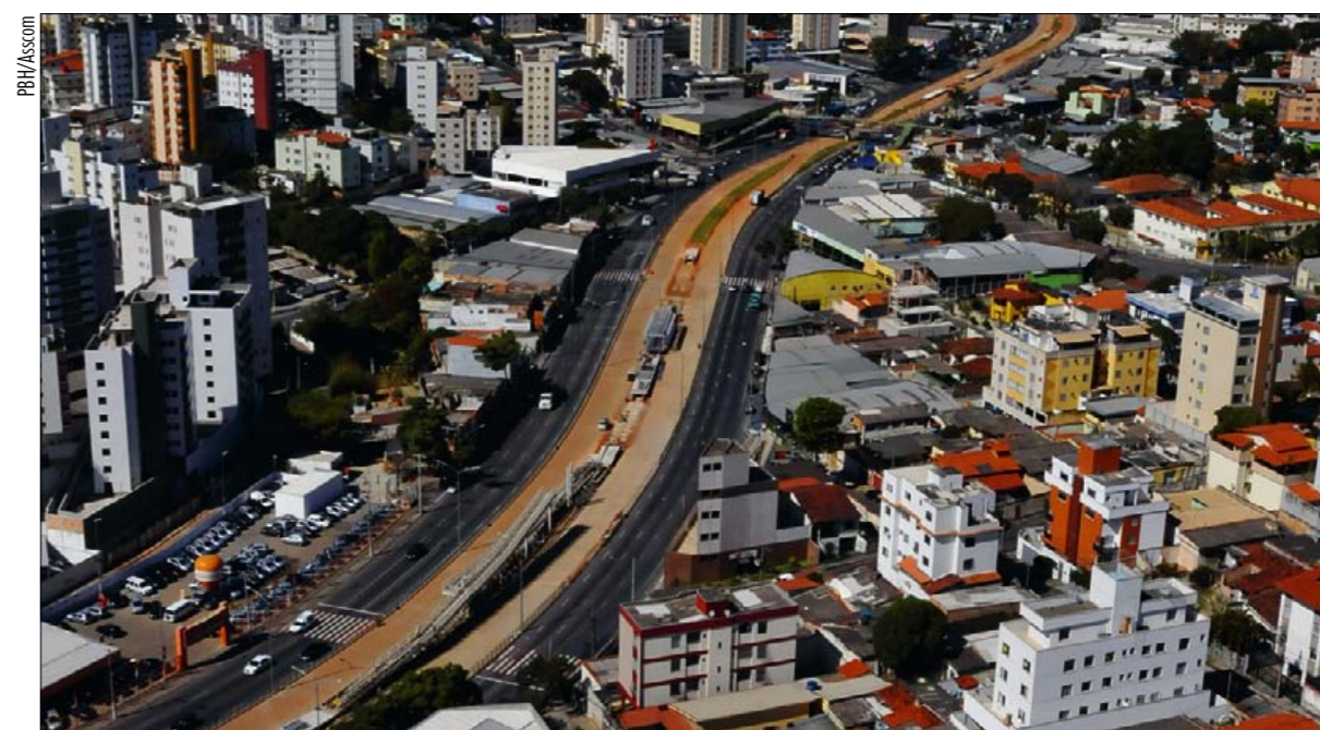
Intervenções em mobilidade urbana de Belo Horizonte pelo TCU permitiram evitar gastos sem paralisar a execução das obras
