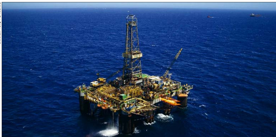
A finalização de plataformas já no mar representa riscos para os trabalhadores, segundo denúncias de sindicalistas
