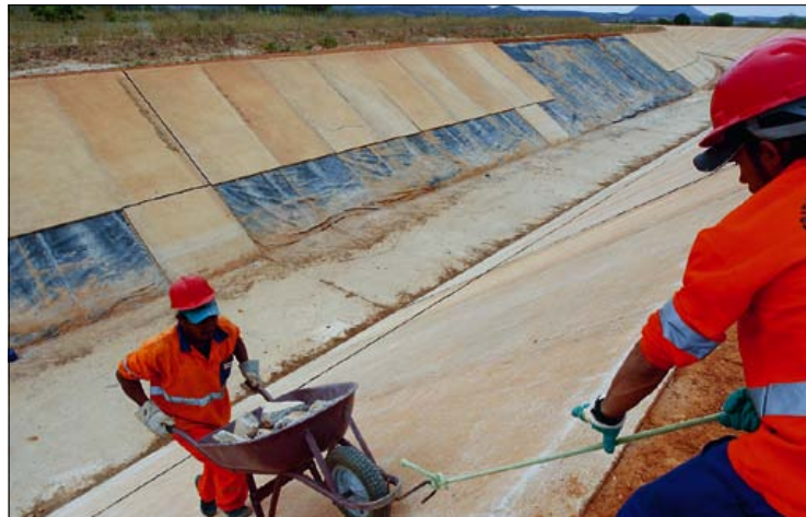
Obras da integração do São Francisco pretendem atender 12 milhões de pessoas
