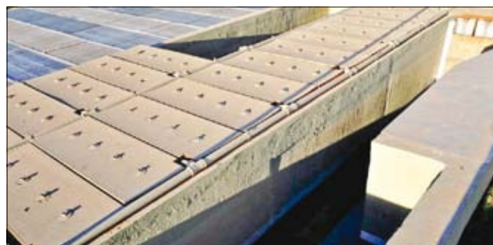
Proposta prevê o fim de tributos para instalação de sistemas de reúso de água
