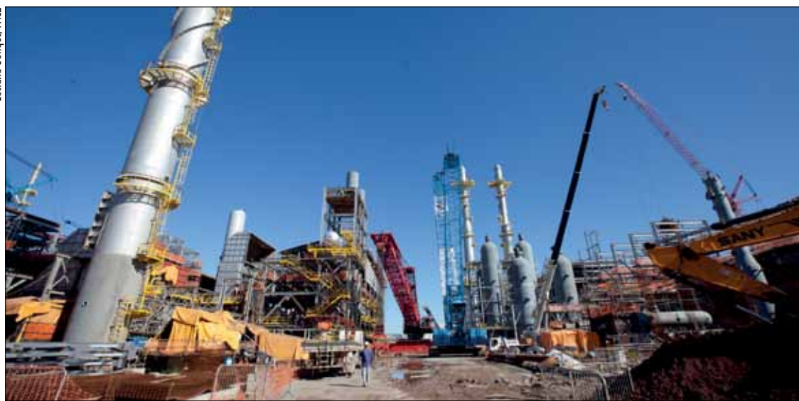
Obras na Refinaria Abreu e Lima, em Pernambuco: Tribunal de Contas da União encontrou irregularidades na construção
