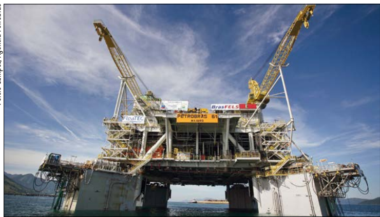
Sindicato dos petroleiros denuncia problemas no lançamento de plataformas
