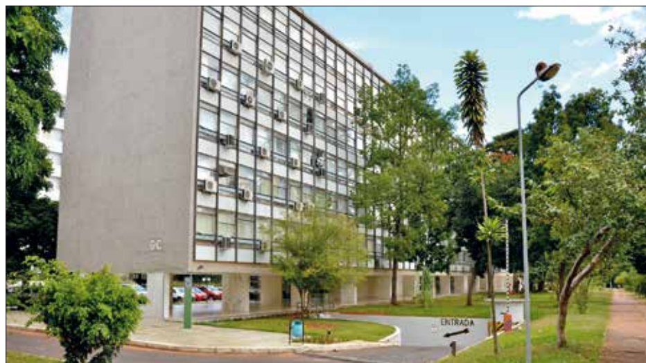
Fachada externa de bloco de apartamentos funcionais dos senadores, na Asa Sul, em Brasília
