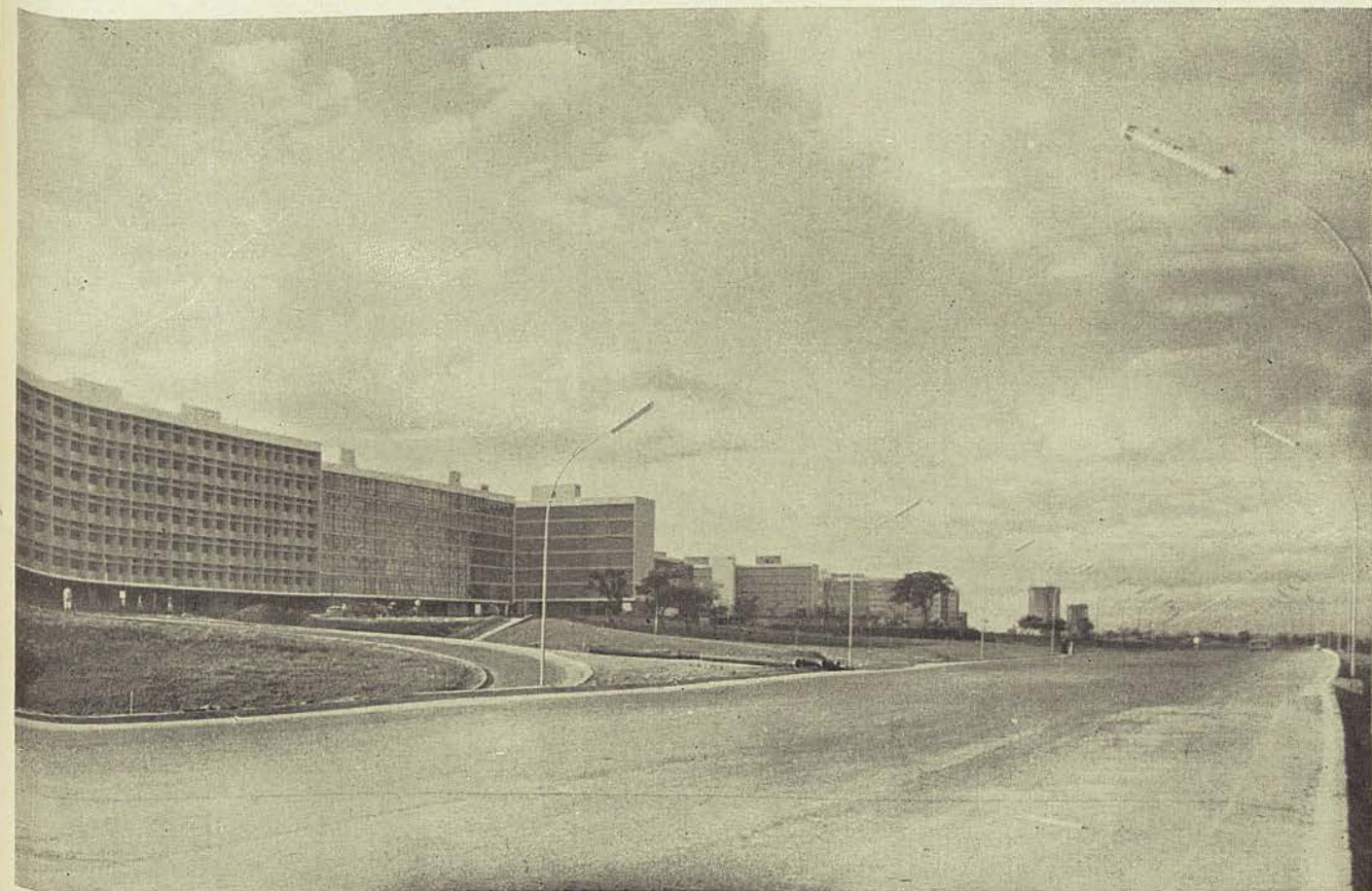
Eixo Rodoviário, setor sul, completamente pavimentado, exibindo sua moderníssima iluminação fluorescente.
