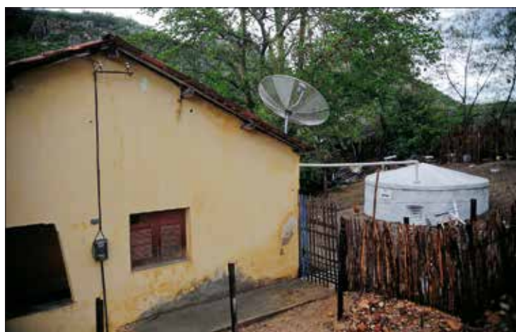
Cisterna para captar e armazenar água da chuva em casa em Quixadá (CE)
