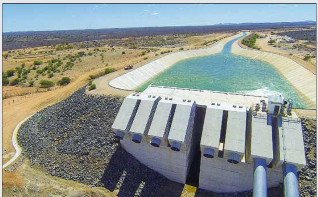
Estação de bombeamento do eixo norte do projeto de integração do Rio São Francisco foi entregue no mês passado
